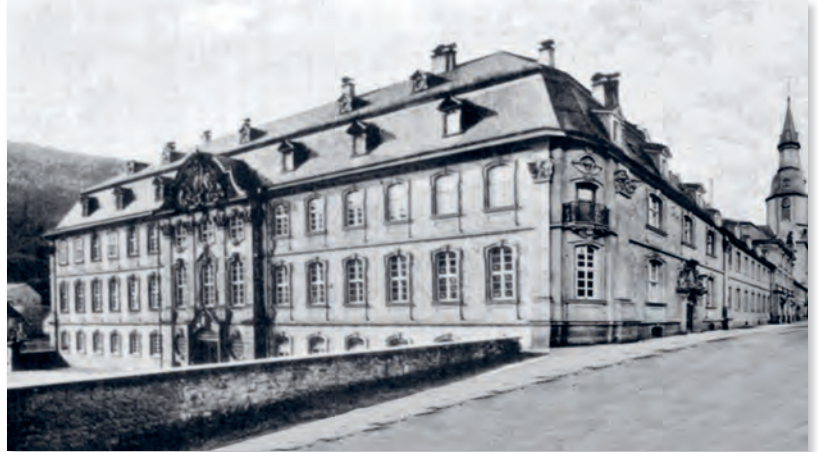
Ursprünglich schmückten die äußere Gebäudeecke ein kleiner Balkon und ein Fenster, die nach den schweren Beschädigungen des Abteigebäudes im Zweiten Weltkrieg leider nicht mehr wiederhergestellt wurden.
