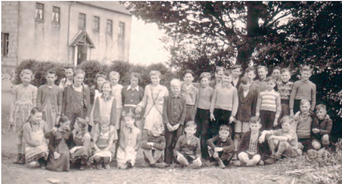
Schüler und Schule in Philippsweiler vor der Renovierung (1957)
